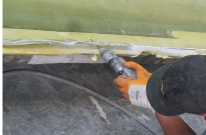
Abbildung 1: Besäumen des Laminats mit handgeführter Stichsäge im Bootsbau
